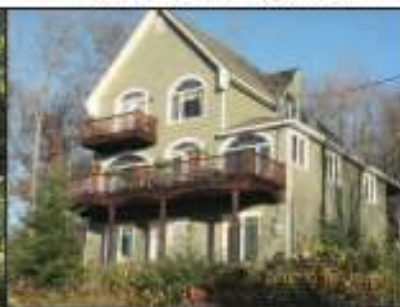
ACCÈS NOTARIÉ QUAI LAC OUAREAU
