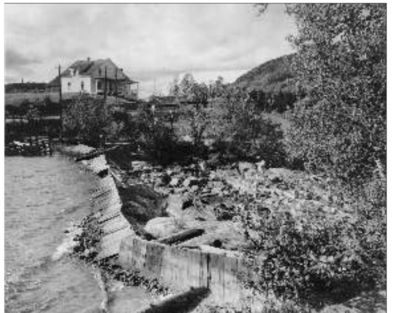
Cette dam était faite d'un ensemble de grandes poutres disposées côte à côte pour former un genre de palissade inclinée. Cette longue suite de poutres était maintenue dans cette position fixe par un ensemble de poutres en forme d'«archiquette» situées en dessous. Le plan incliné faisait alors face au lac à contre-courant. Pour assurer l'étanchéité de cette dam, du sable et des roches étaient amoncelés sur le plan incliné pour assurer une solidité et une longévité.
